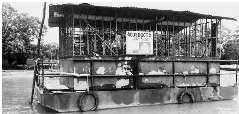
Foto N° 12. Bocatoma acueducto del Municipio de Puerto Leguízamo – Putumayo.
