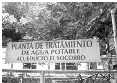
Foto N° 10. Planta de Tratamiento de agua potable del acueducto El Socorro, Envigado, Antioquia.
