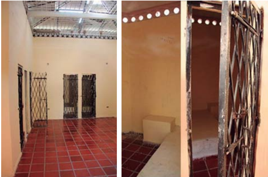
Imagen 31: Cali. Centro de Observación Juvenil Valle del Lili (CAE / CIP). Observación. Vista izquierda panorámica general. Vista central y derecho: detalle celdas de aislamiento.
