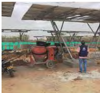
Foto 19. Zonas de Parqueo.
