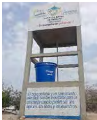
Foto 3. Tanque de almacenamiento.
