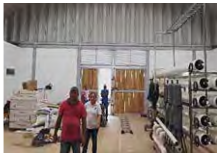
Foto 17. Tanques de paso.
