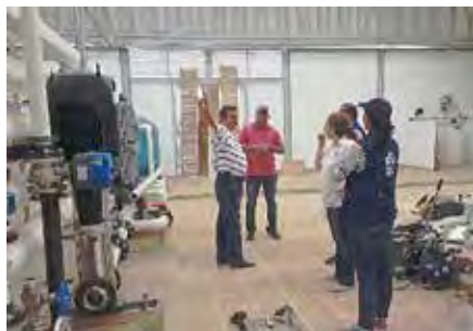
Foto 16. Zona de Almacenamiento.
