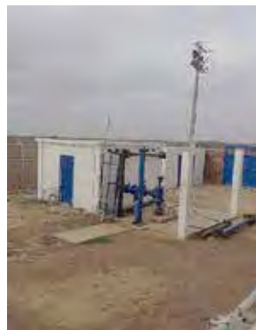
Foto 8. Zona de Pozo.
