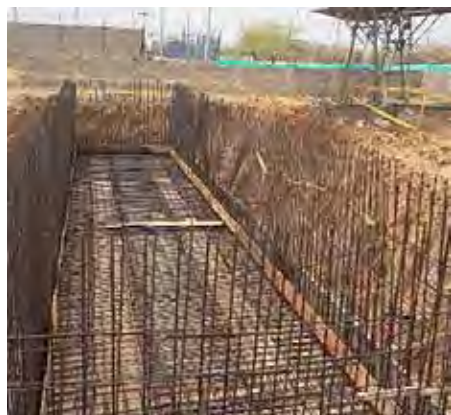
Foto 21. Tanque de almacenamiento.
