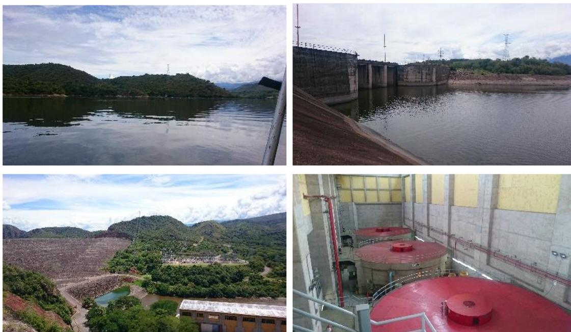
**Fuente:** Defensoría del Pueblo, 2016. La represa cuenta con tres turbinas tipo Francis de eje vertical, cada una con una potencia de 180 MW.
